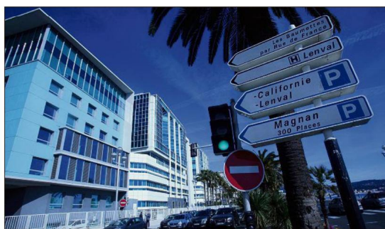
Cinq mois de travaux du côté de Santa Maria, ont été nécessaires pour préparer trois étages du bâtiment de la fondation Lenval à une arrivée confortable dans la vie. (Photo Jean-François Ottonello)
